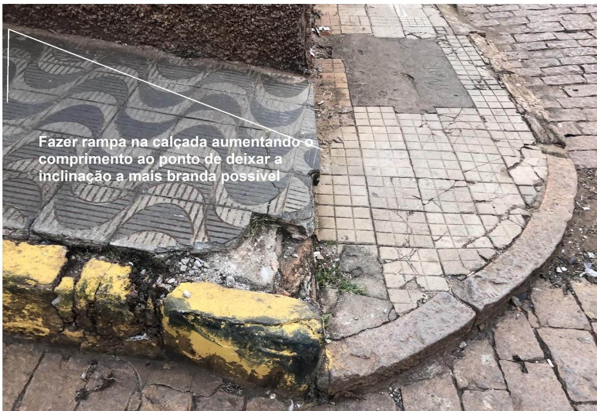
Retirada de degrau na calçada e construção de rampa de acessibilidade
