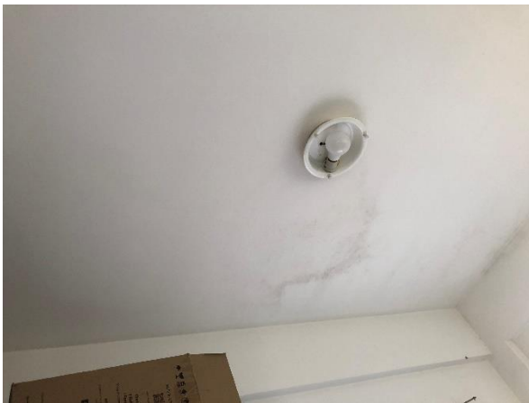
Infiltração no piso
