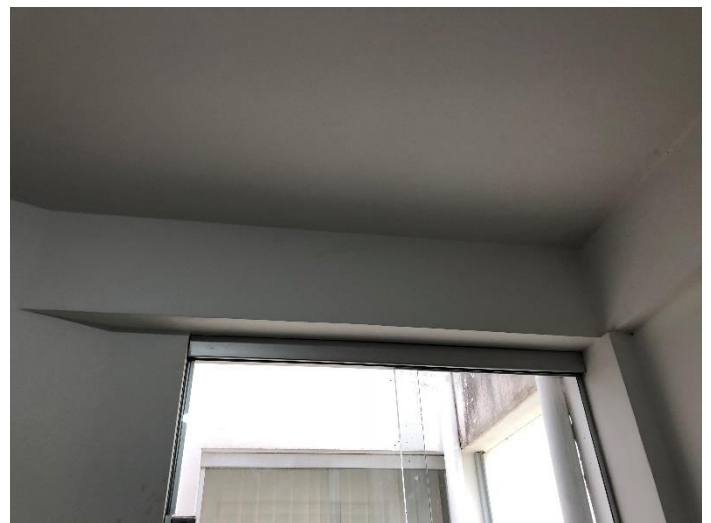
Teto aparentemente sem anomalia
