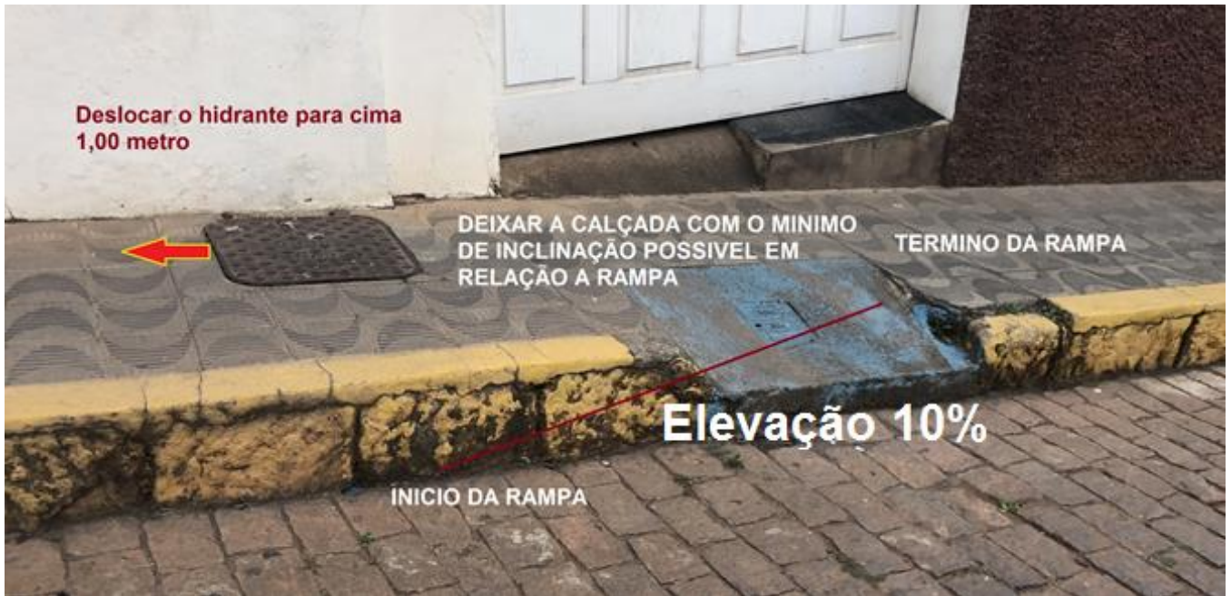
Detalhe de construção da rampa de acesso ao predio, sem prejudicar a calçada
